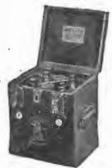
Batteria Tudor 2 C 5 4 Volt, 65 Amperora per accensione filamento.
