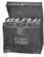
Batteria Edison 5B 2 da 37,5 Amperora per accensione filamento
